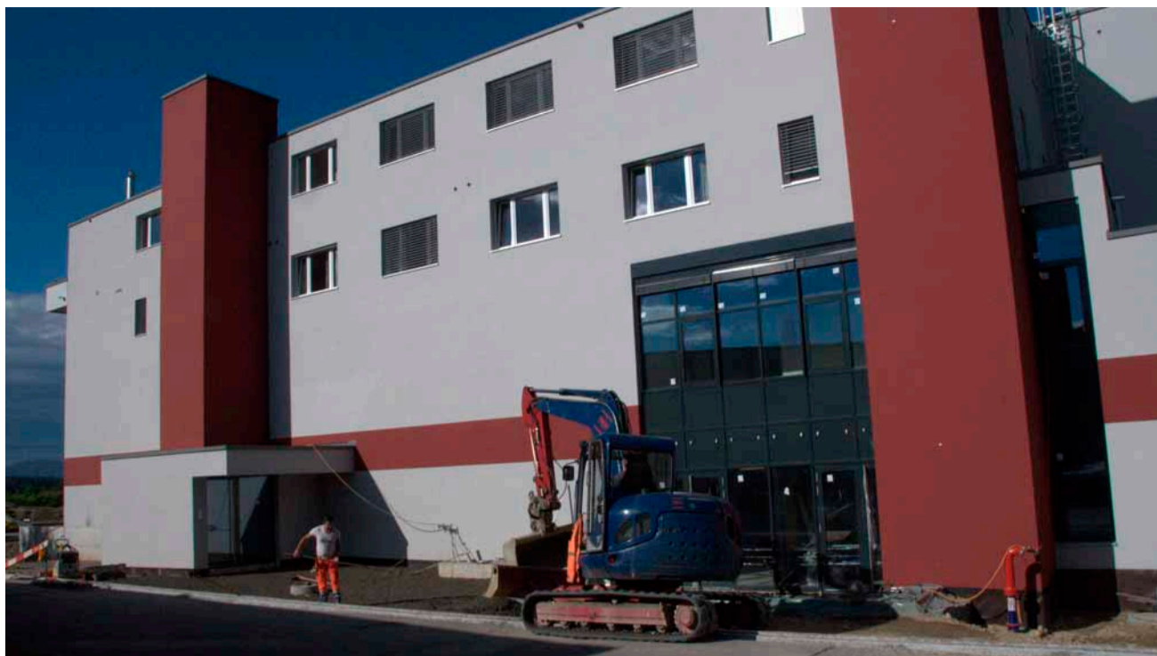
Letzte Arbeiten am neuen Kinokomplex Cinema 8 in Schöffland.
