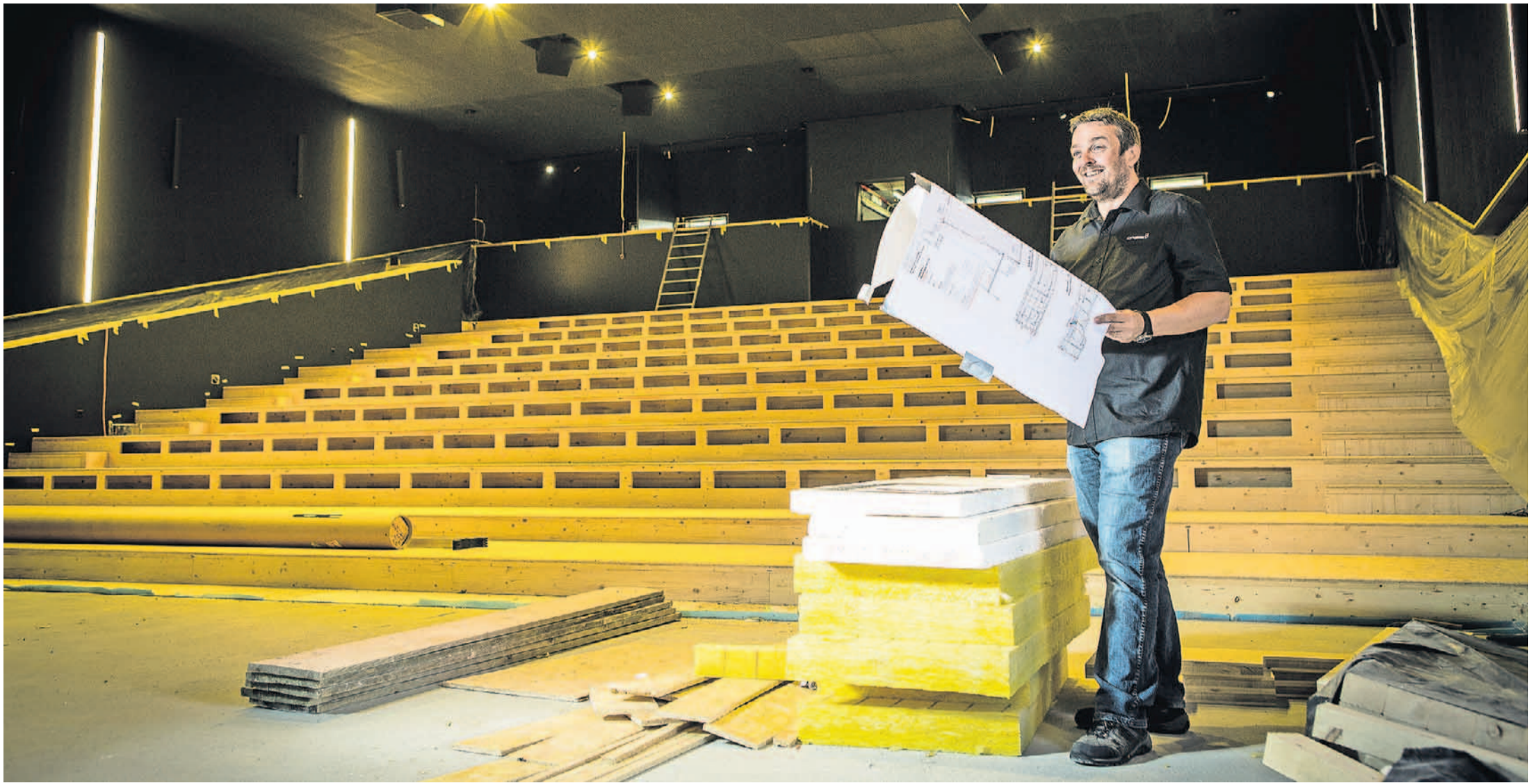
Rolf Häfeli im Kinosaal 5: Lichter und Lautsprecher sind bereits montiert, bald wird der Teppich verlegt. Die Logen im hinteren Teil des Kinosaals sind direkt mit vier Themenzimmern verbunden.
